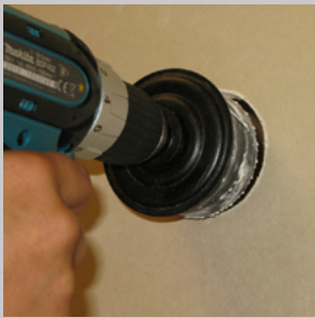
Mät upp och borra ut med en 74mm multifräs. (16 047 26)
