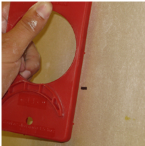
Markera centrumhöjden där dubbeldosan ska monteras. Använd piggarna på långsidan ...
