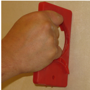
... och tryck mot väggen, med piggarna på varje sida av den markerade centrumhöjden.
